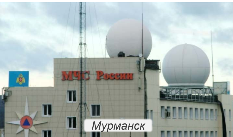
Приемные комплексы КПИ-3.6 (диаметр антенны 4 м) Госкорпорации «Роскосмос» и в центре МЧС России
