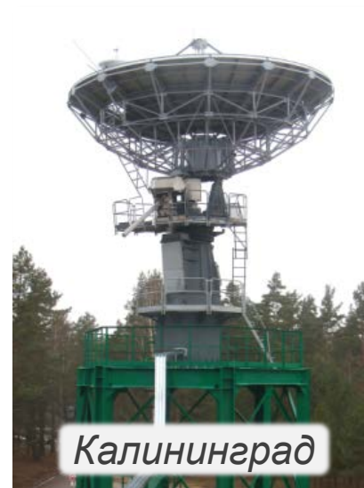
Приемные комплексы ПК-9 (диаметр антенны 9 м) в центре Росгидромета и Госкорпорации «Роскосмос»
