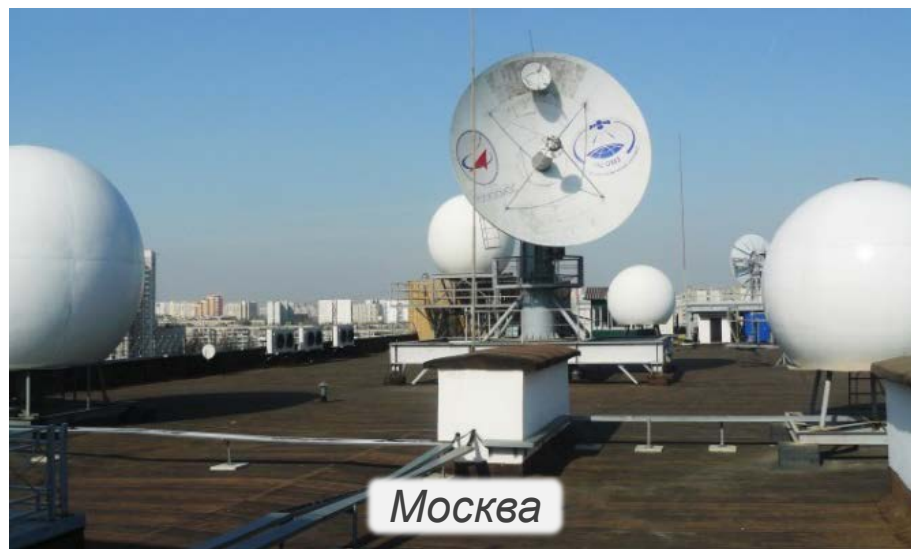
«Антенное поле» на крыше здания Оператора космических средств ДЗЗ (НЦ ОМЗ АО «Российские космические системы»)
